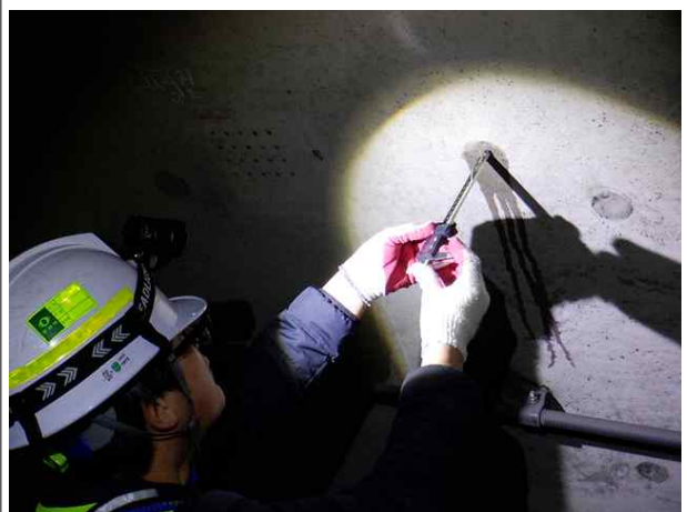
탄산화 깊이 측정
